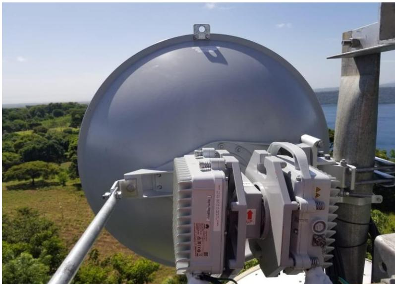
Nota. Foto tomada durante mis trabajos en campo correspondiente a proyectos de radioenlaces de alta disponibilidad para Claro Nicaragua, la antena se encuentra a 30 metros de altura, y se dirige hacia una torre ubicada en el centro de Granada Nicaragua. Nótese el tamaño del receptor parabólico para concentrar la mayor parte de la emisión de microondas en un punto focal, aumentando así su ganancia. Fuente propia.
