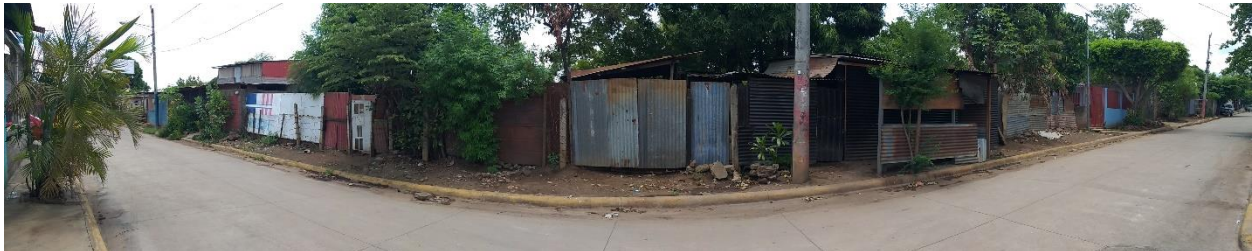
Ilustración 3. Estado Físico De Las Viviendas. Elaboración Propia 2019.
