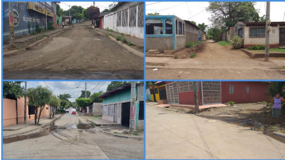
Ilustración 7. Estado de las Vías. Elaboración Propia 2019.
